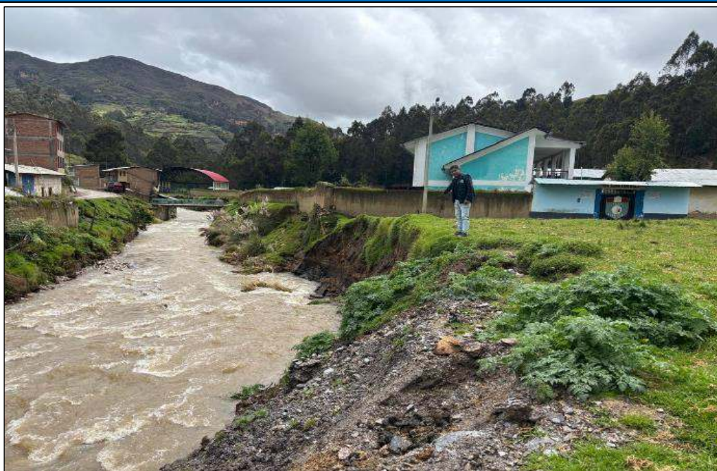
Figura N° 01. Se muestra la erosión en la margen del río Libertad, afectando el muro de contención de una institución educativa y poniendo en riesgo la infraestructura y terrenos agrícolas cercanos.
